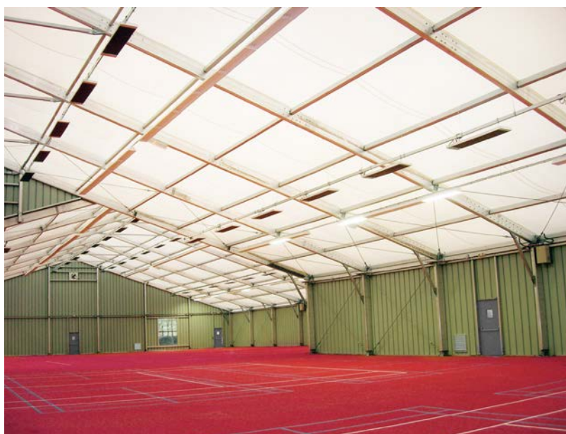
La mise en chauffe de l'EZ300 est très rapide, sans préchauffage, ce qui désigne particulièrement ce mode de chauffage pour locaux occupés sur une base irrégulière.
