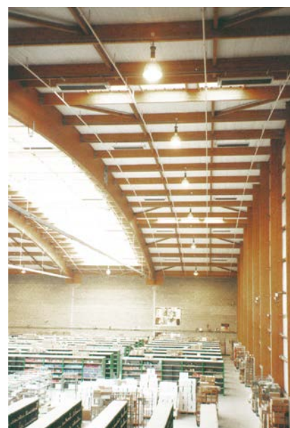
Les cassettes rayonnantes sont particulièrement adaptés aux locaux à grande hauteur sous plafond (aucune déperdition de chaleur entre cassette et sol).
