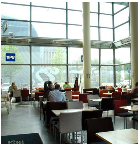
Le chauffage IR peut être positionné suivant des angles différents afin d'orienter la chaleur où elle est nécessaire. Les émetteurs utilisés en extérieur doivent être placés sous un toit.
