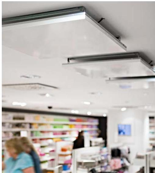
El montaje en techo protege los paneles Thermocassette de cualquier daño.
