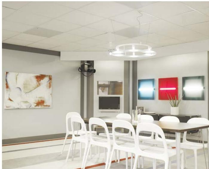
Montados en un falso techo, los paneles Thermocassette proporcionan una calefacción agradable y casi invisible. Además, en caso de reforma se pueden cambiar de sitio con gran facilidad.
